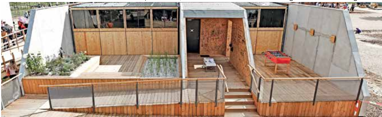
Rooftop: Holzhaus, das auf das Dach eines Altbaus aufgesetzt wird und Energie liefert.
